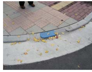
勾配が緩やかで車椅子のため一部段をなくした摺り付け
