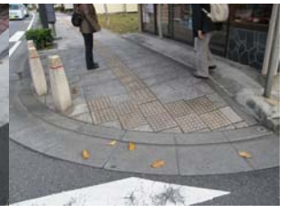
勾配が急な摺り付け
